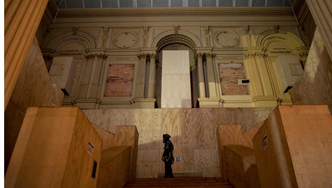
Estátua de D. Pedro I foi protegida com tapumes durante a obra
