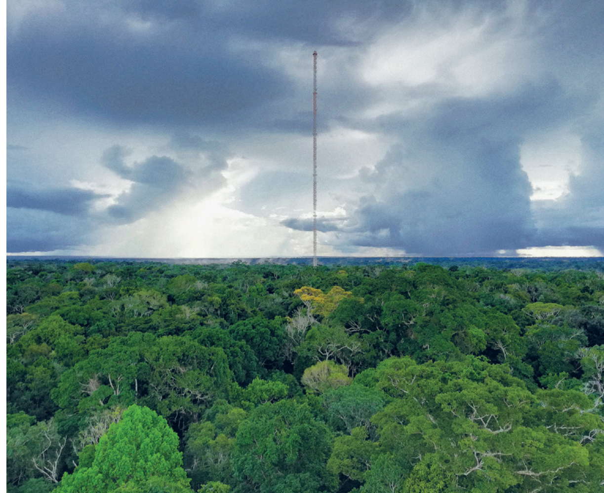
Observatório da Torre Alta da Amazônia (Atto), 325 metros de altura, para registro de dados meteorológicos, químicos e biológicos
